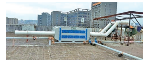
车间顶层安装活性炭过滤箱
